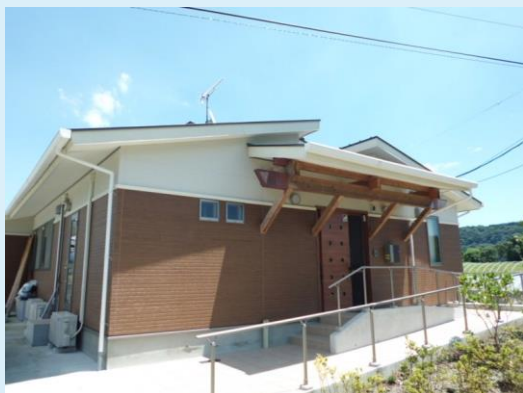
グループホーム 3棟
