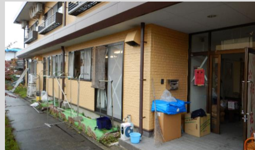
建物被害は全壊判定（赤紙）だった (4月24日午後)
