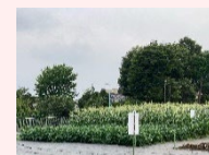
園地、園路整備
